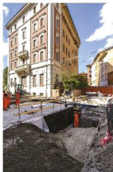
↑ Il cantiere sul Ravone in via Saffi (agosto 2023)
