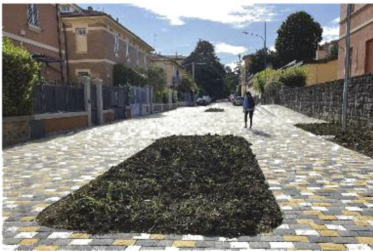
↑ I lavori in via Perti
